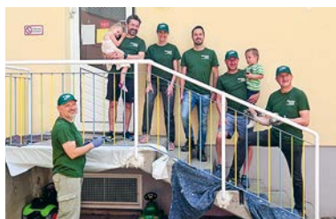
Das Geländer in den Garten der Kita Maria Saal wurde von den Mitarbeitenden der KNG – Kärnten Netz GmbH neu gestrichen.
