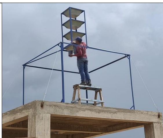
Actividad: Instalación sistema de tratamiento
