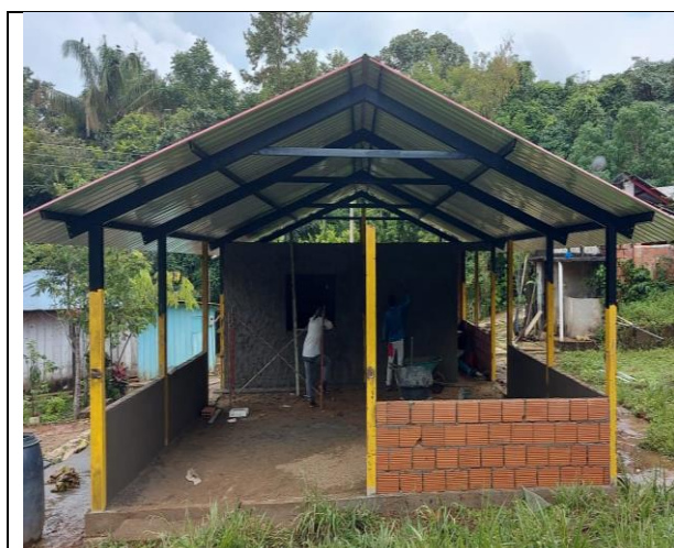
Actividad: Pañete muros
